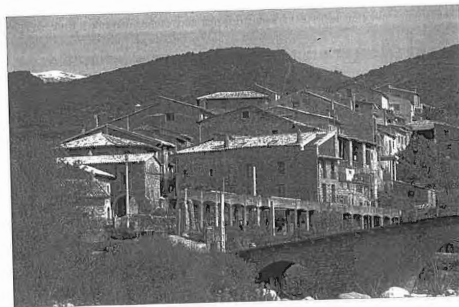
18.- La Puebla de Roda y el puente sobre el Isábena
