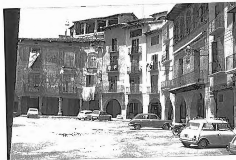
17.- Graus. Plaza mayor y del mercado, antes de su restauración
